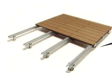
10 床板設置完成
